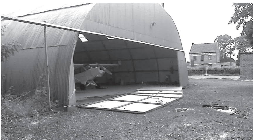
Tijdens de storm van 14 juli lag de poort van de loods zwevers tegen de grond.
