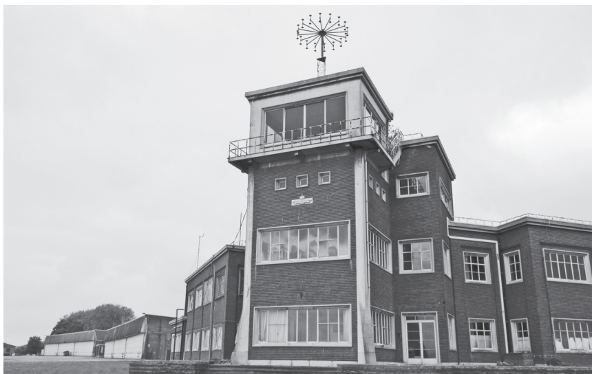
De controletoren van de vroegere EVS
